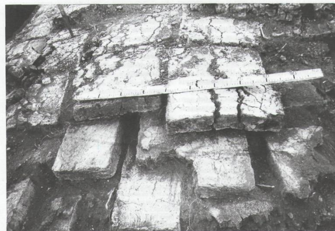
Рис. 12. Вид системы расположения кирпичей в кладке стены
