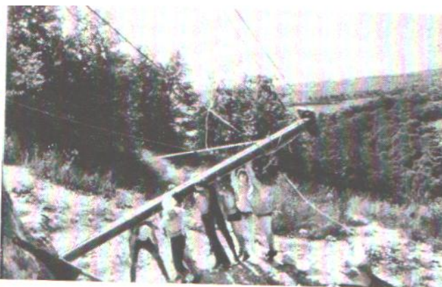
Рис. 1. Процесс установки опоры (фото из личного архива С.В. Никольского)
