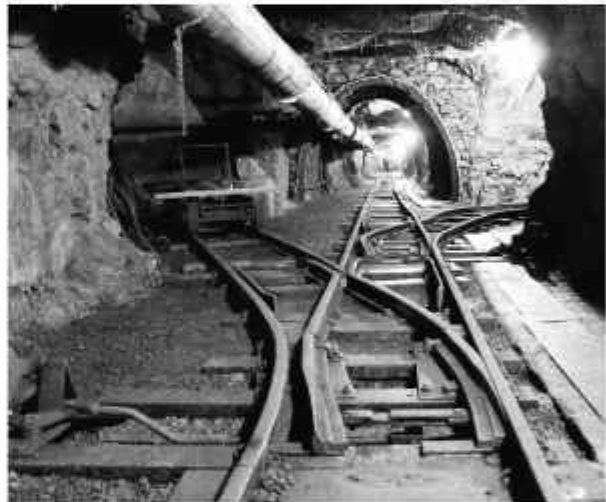
Рис. 3. Штольня №1 Fig. 3. Adit №1
