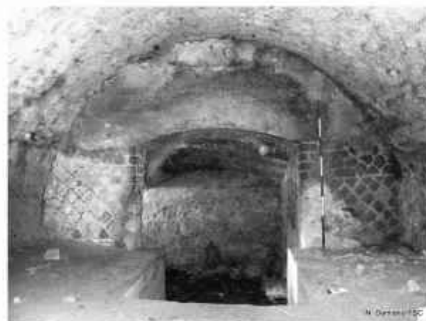
Fig. 5. The inner wall of the bunker "Underground chamber" Рис. 5. Внутренняя стенка бункера "подземная камера"
