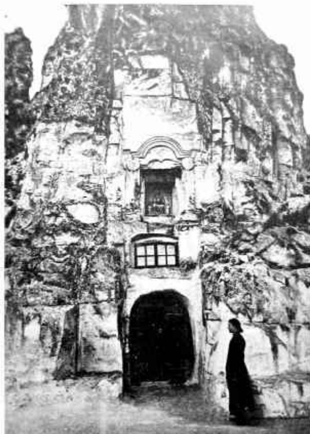
Рис. 5. Вид на центральный фасад пещерного комплекса в Больших Дивах с церковью Сицилийской иконы Божией Матери. Фото начала XX в. Fig. 5. View of the central facade of the cave complex in Bolshie Divy with the church of Sicilian icon of Our Lady. Photo of the beginning of the XX century
